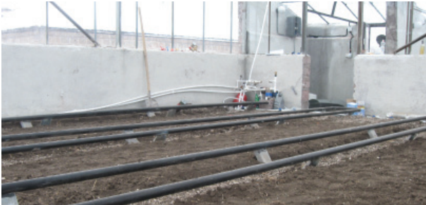
Ուսումնացուցադրական ջերմոցի ջեռուցման համակարգը
